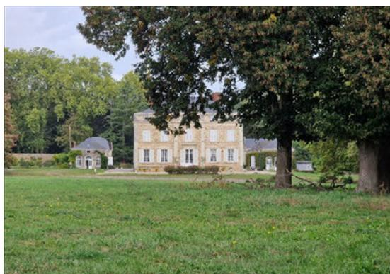
Les toitures présentent une pente de 45° et deux ou ponctuellement quatre pans. Elles sont couvertes d'ardoise et parfois de bac acier de teinte ardoise, une solution pour les bâtiments annexes qui s'accorde bien avec l'existant.
